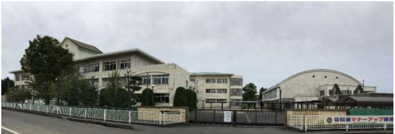
▲写真 川島中学校校舎（全景・校門から）
